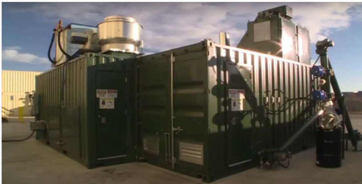
トライジェンパワー松阪発電所が採用した木質熱分解ガス化CHP(写真提供:トライジェンパワー)
